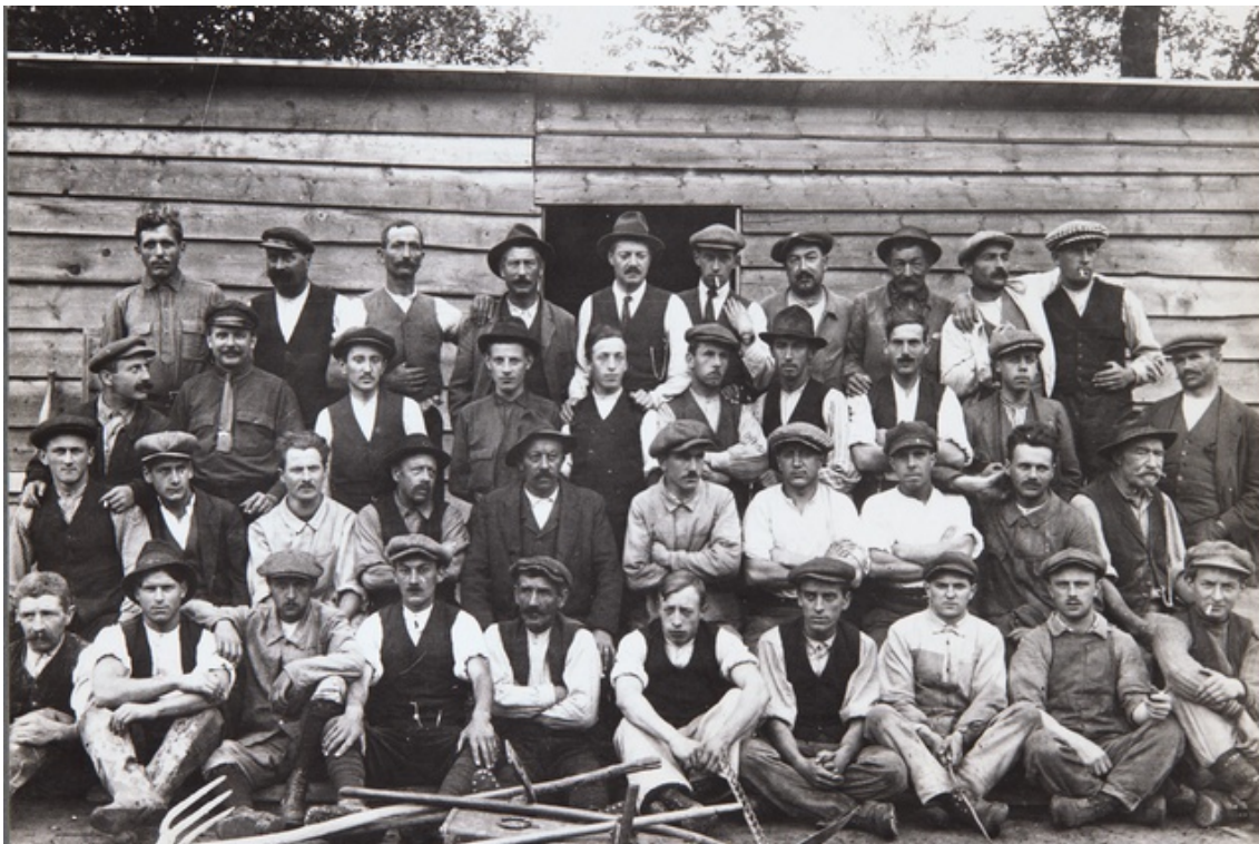
Des ouvriers sur le chantier de ce qui deviendra l'aéroport de Genève, en 1920.(Geneva Airport)
