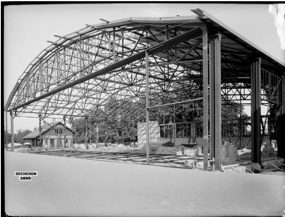
La construction d'un hangar, en 1928.(Geneva Airport)
