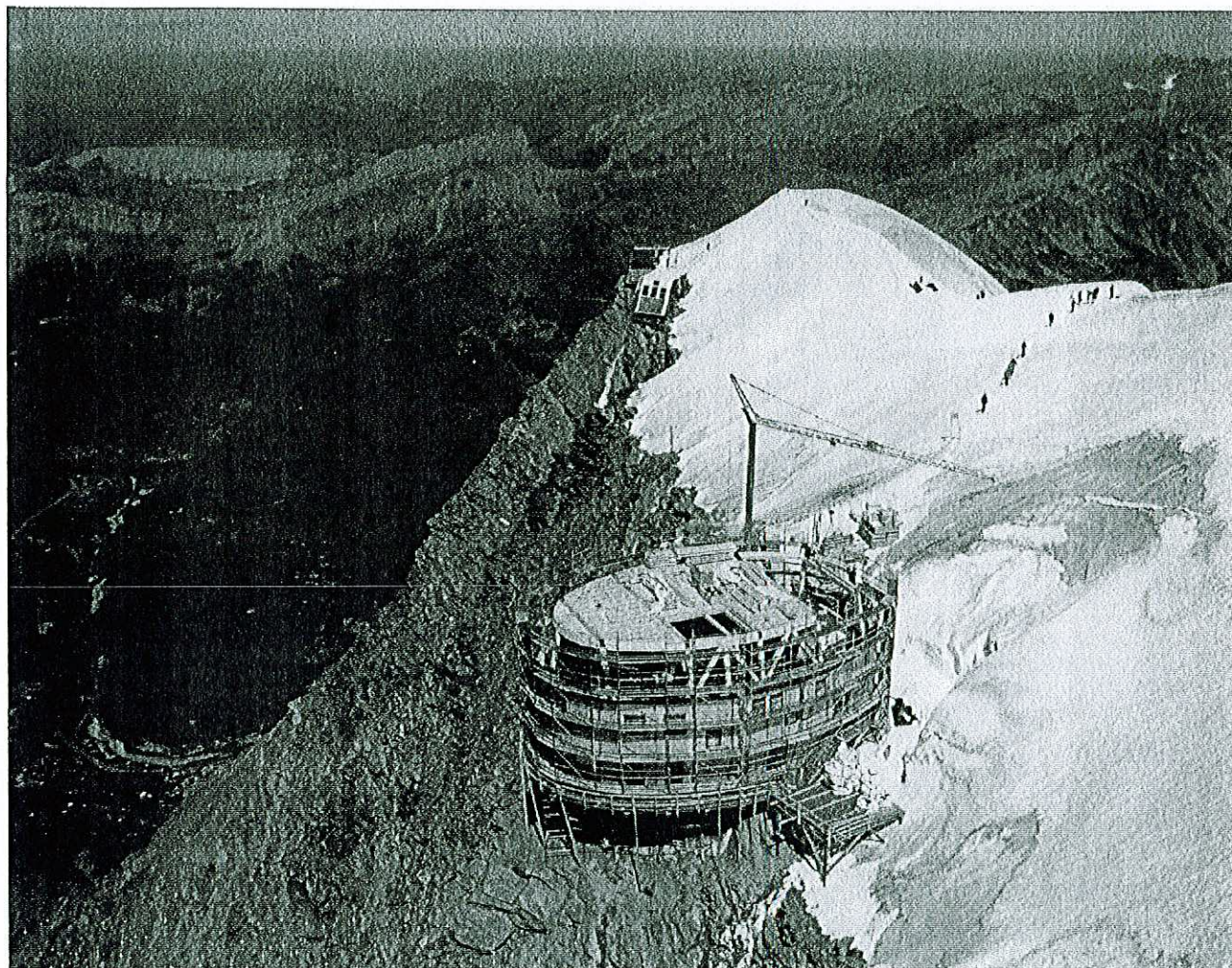
Ancrée dans la roche sur le dénivelé de 1500 mètres, la structure bois est hélicoptérée et montée sur place
